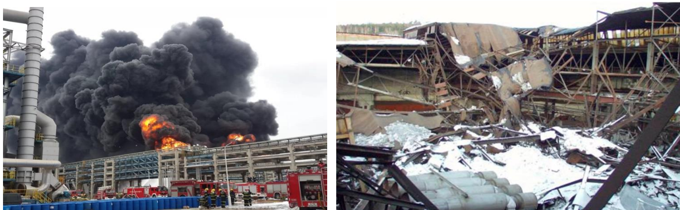
Рис. 2. Последствия пожара на объекте ТЭК
